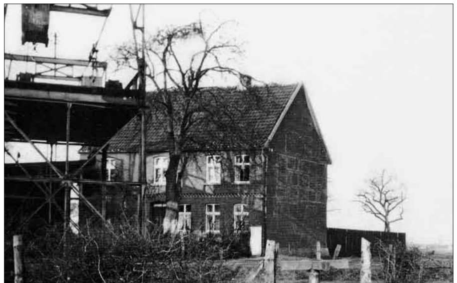
Haus mit einer Schutzbrücke (ca. 1920) an der Straße „Auf der Mühle“ Nr. 20 in Dortmund-Brackel
